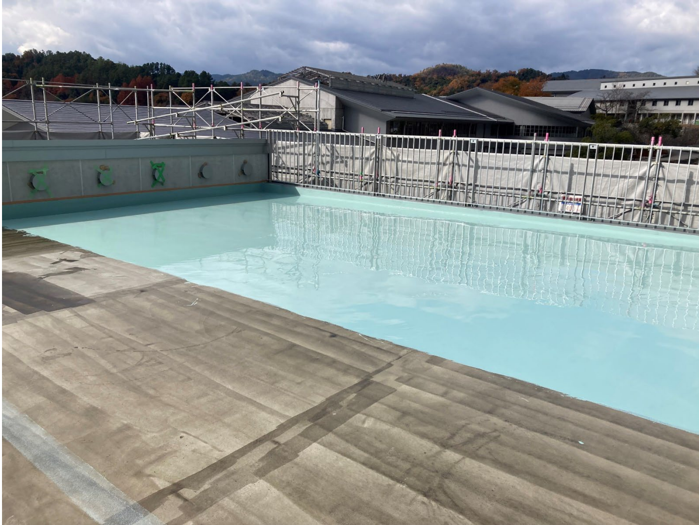
防水施工状況（プライマー・エバーコート）
