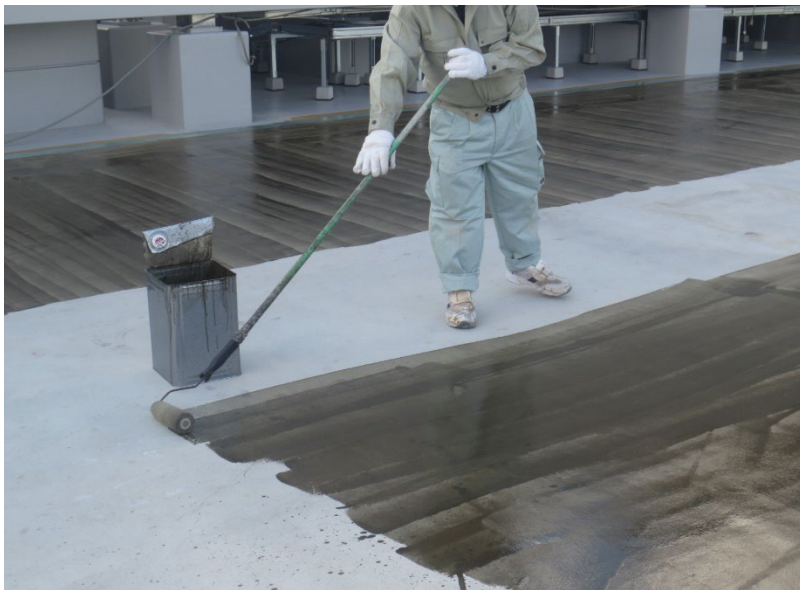
工程①プライマー塗り
