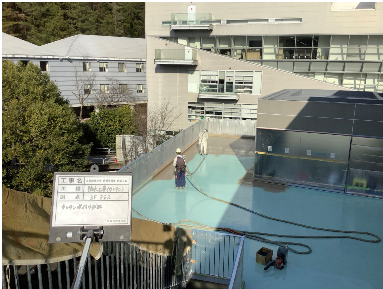
防水施工状況（超速硬化ウレタン吹付）
