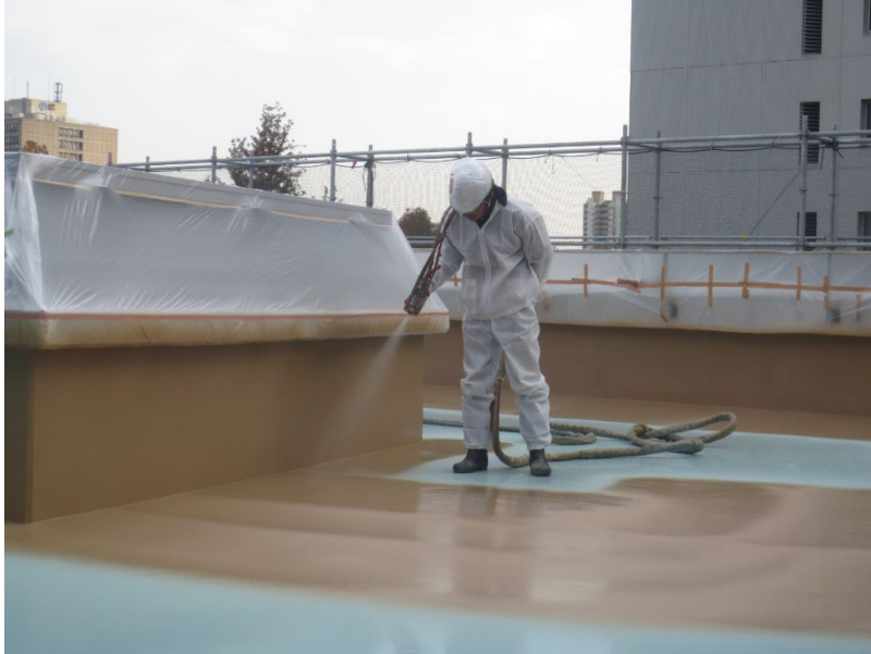
工程③超速硬化ウレタン防水吹付け
