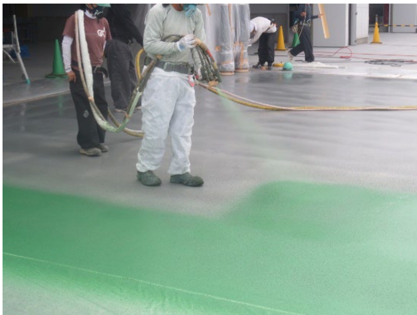
＜吹付け施工の様相＞
