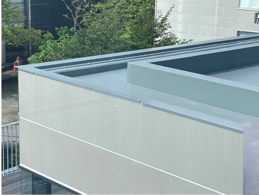
外壁・パラペット立上り
