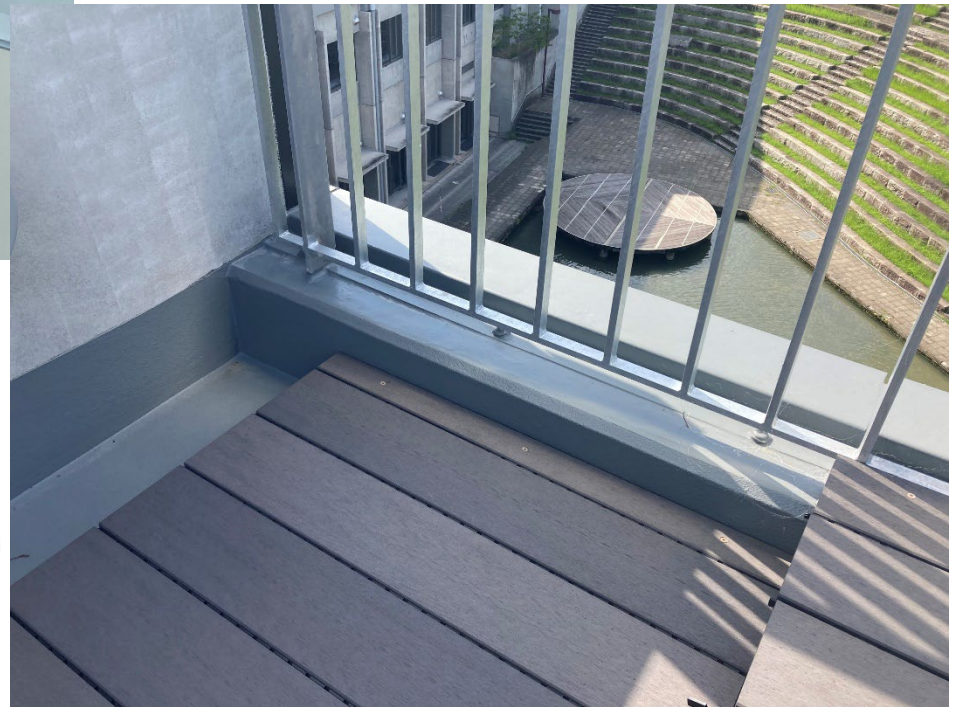
側溝・手摺立上り
