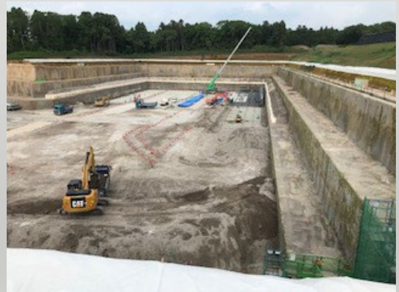
※現場状況写真
