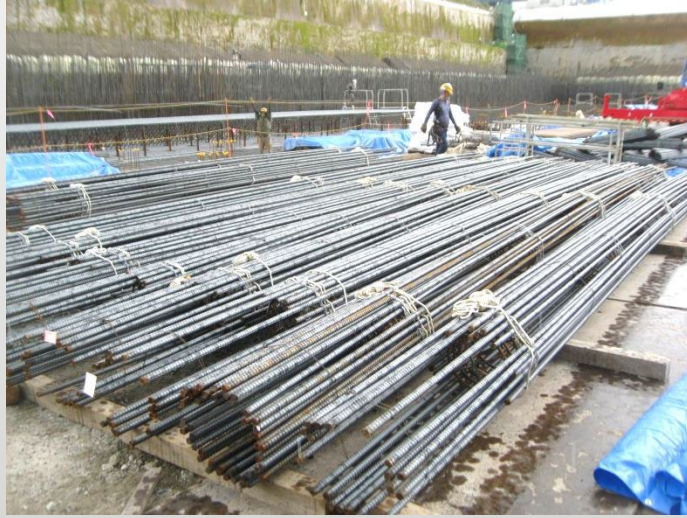
現場搬入状況
