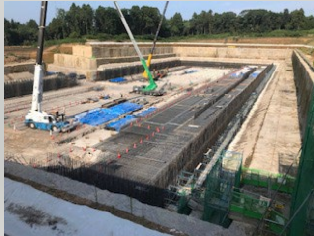
現場全体状況
