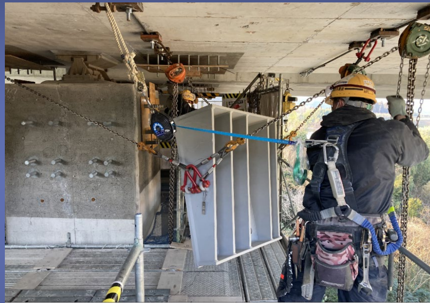
引き込み・回転状況
