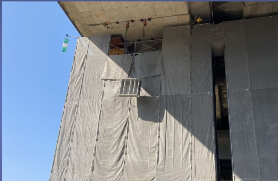
吊り上げ状況
