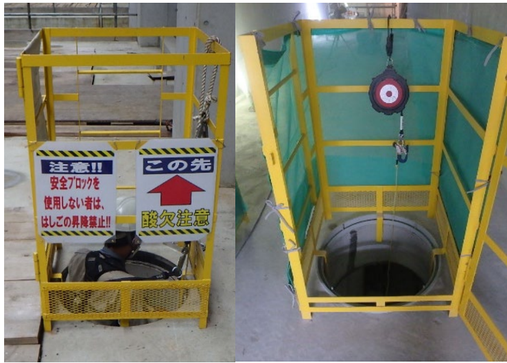
開口部養生柵
