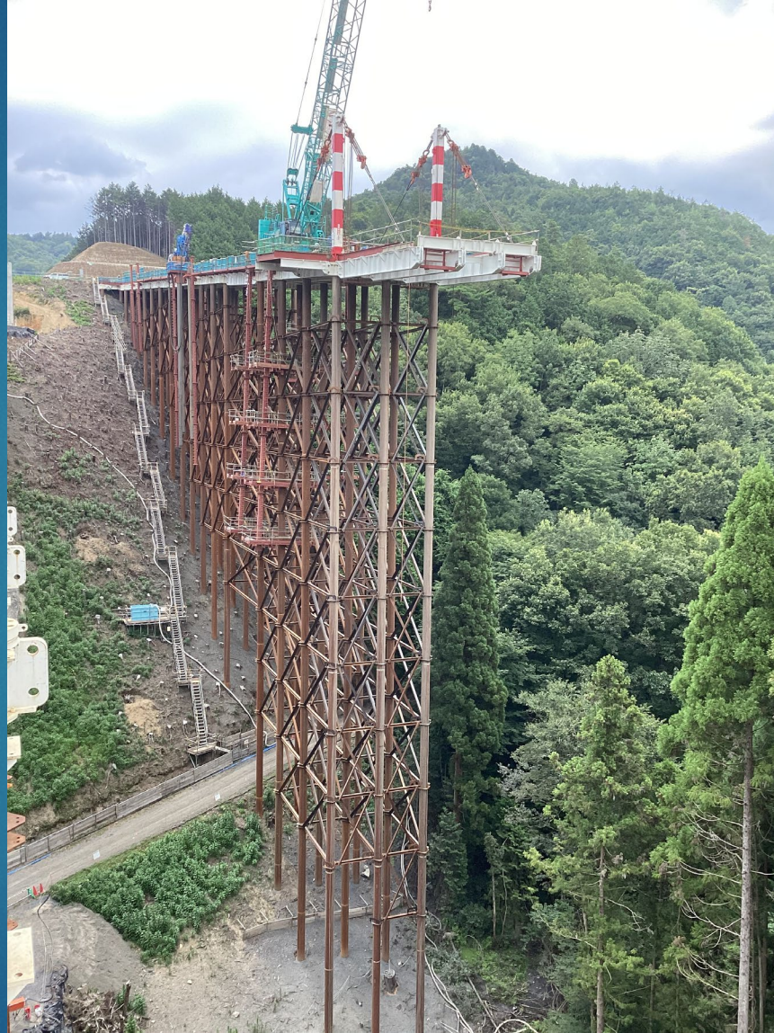
上部工（メインフレーム）架設
