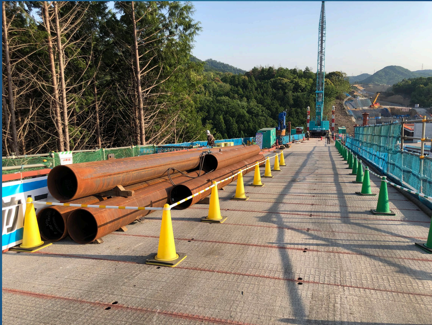
栈橋上部覆工面全景
