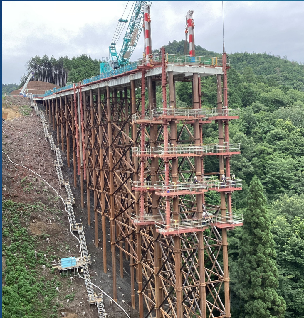
下部工（ブレース材）設置
