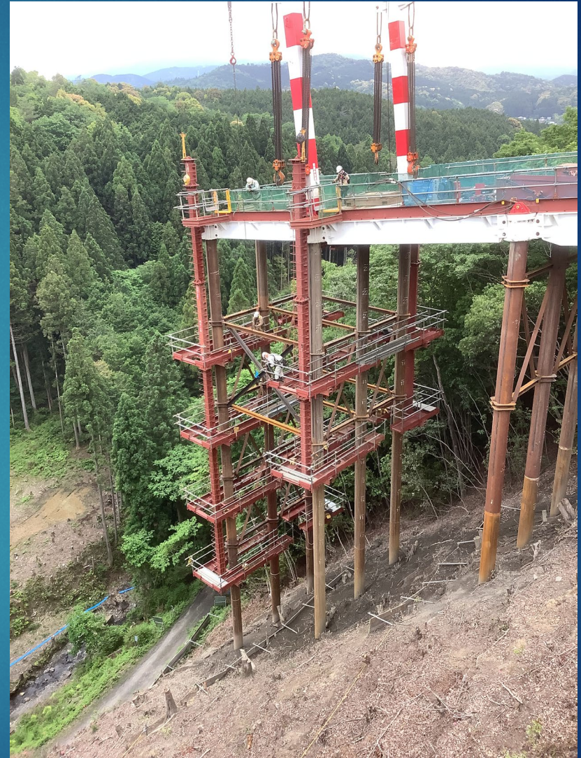
下部工（ブレース材）設置
