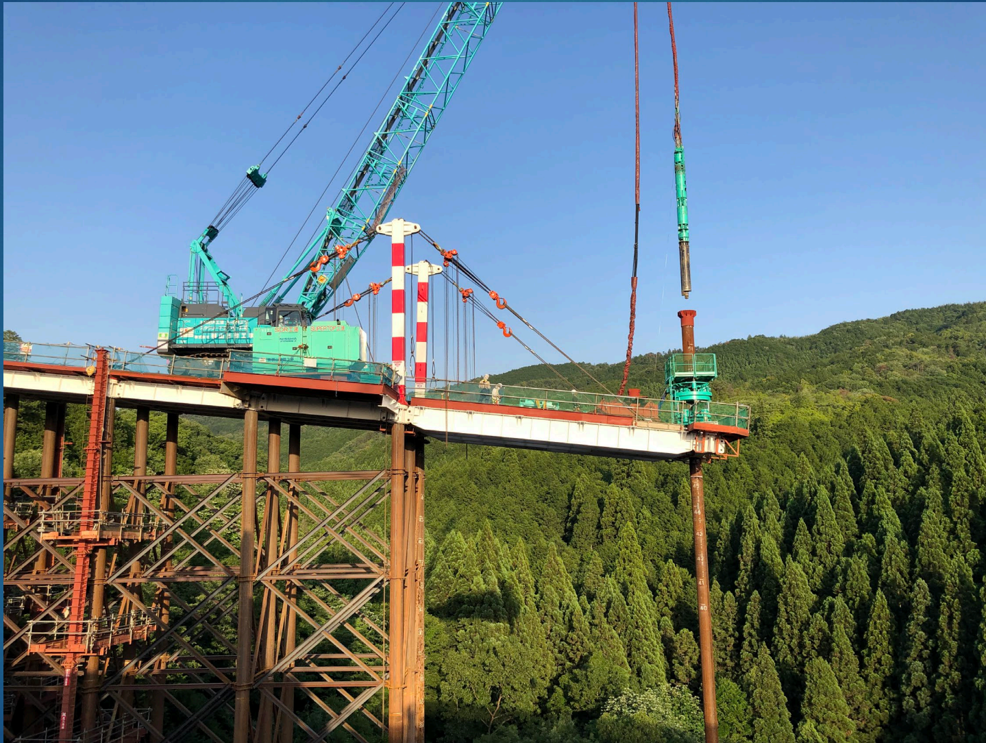
支持杭打込み（ピラードライブシステム）
