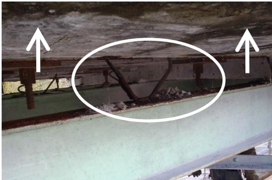
□既設床版と主桁の遊間にサンドル材を設置し仮受け支持。
