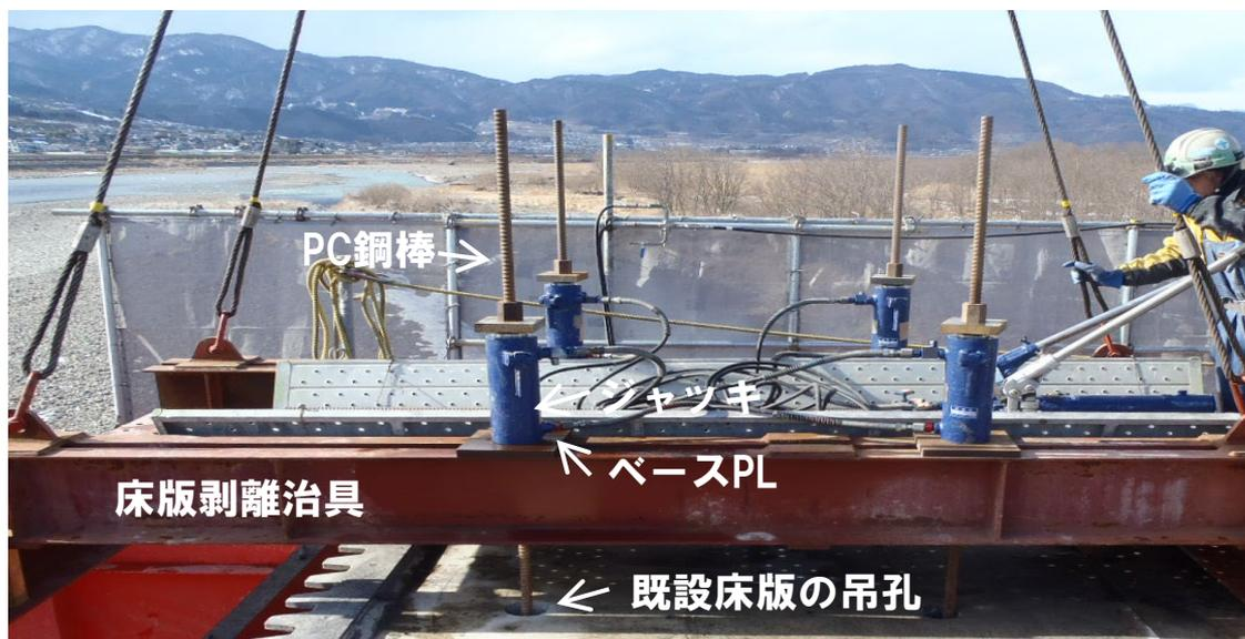
床版剥離治具上にベースプレートを敷き、その上にジャッキを置き、PC鋼棒を既設床版の吊孔に挿入し、床版剥離治具と既設床版を固定していた。
