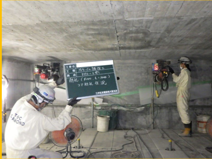
横桁削孔状況
