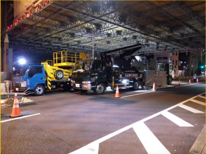
コンクリート打設状況(桁下ポンプ車据付)
