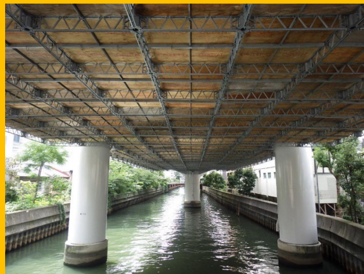
吊り足場組立完了
