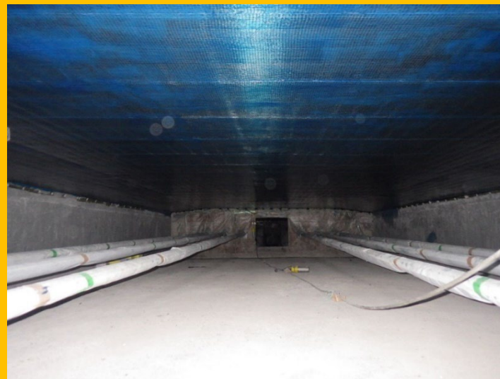
炭素繊維シート貼り付け 大阪支店真栄会 (土木部会)
