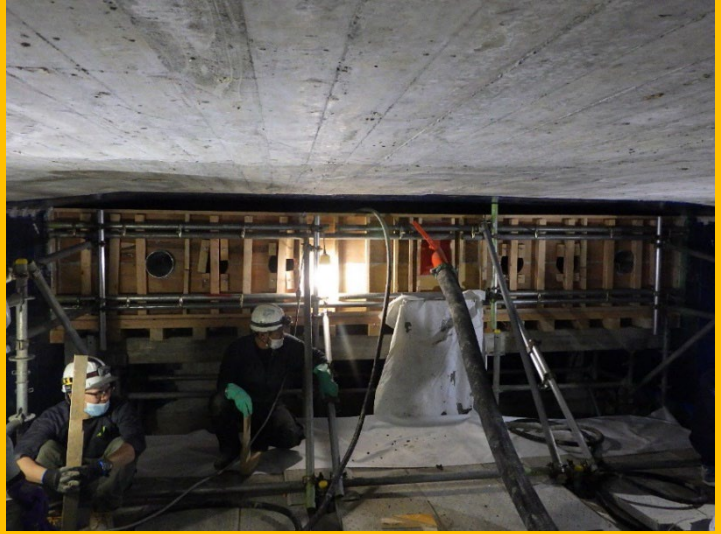
コンクリート打設状況(柱頭部突起)
