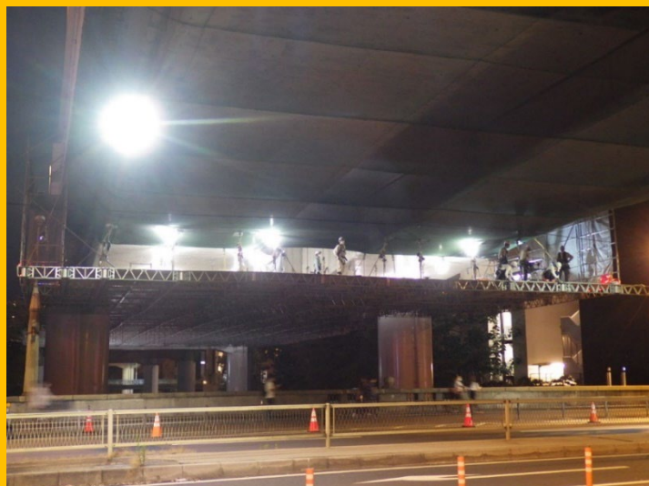
吊り足場組立状況
