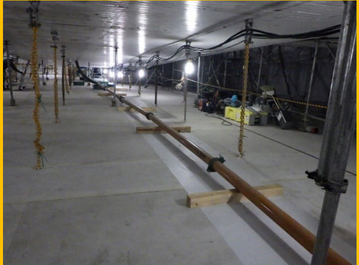
コンクリート打設状況(吊り足場内配管)
