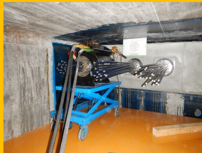
外ケーブル緊張状況
