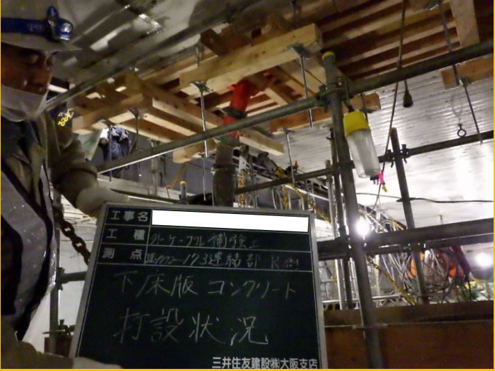
コンクリート打設状況(連結部下床版・ウェブ)
