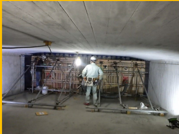
偏向部横桁鉄筋・型枠組立状況
