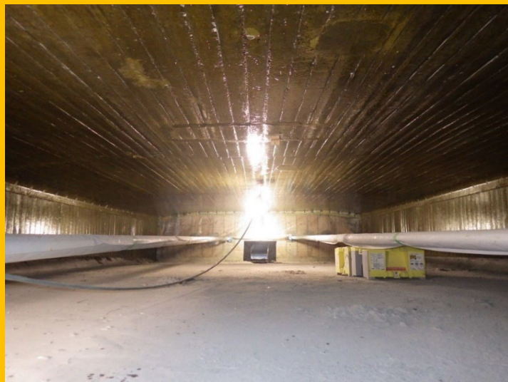
下地処理・プライマー
