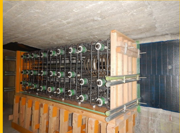
ウェブ定着突起鉄筋・型枠組立状況
