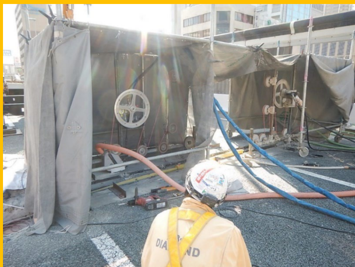
連結部上床版撤去状況(ワイヤーソー切断)
