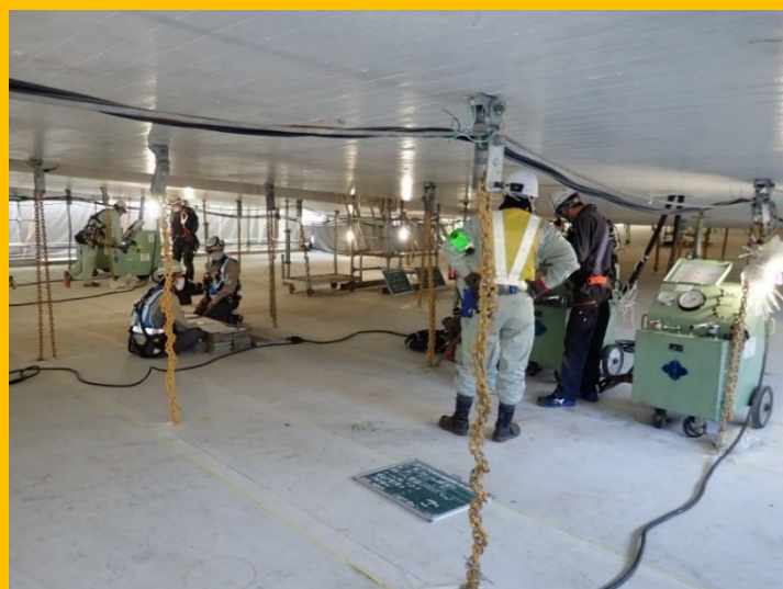
外ケーブル緊張状況
