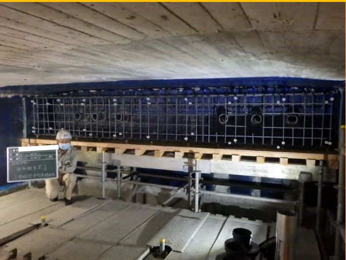
柱頭部定着突起鉄筋・型枠組立状況
