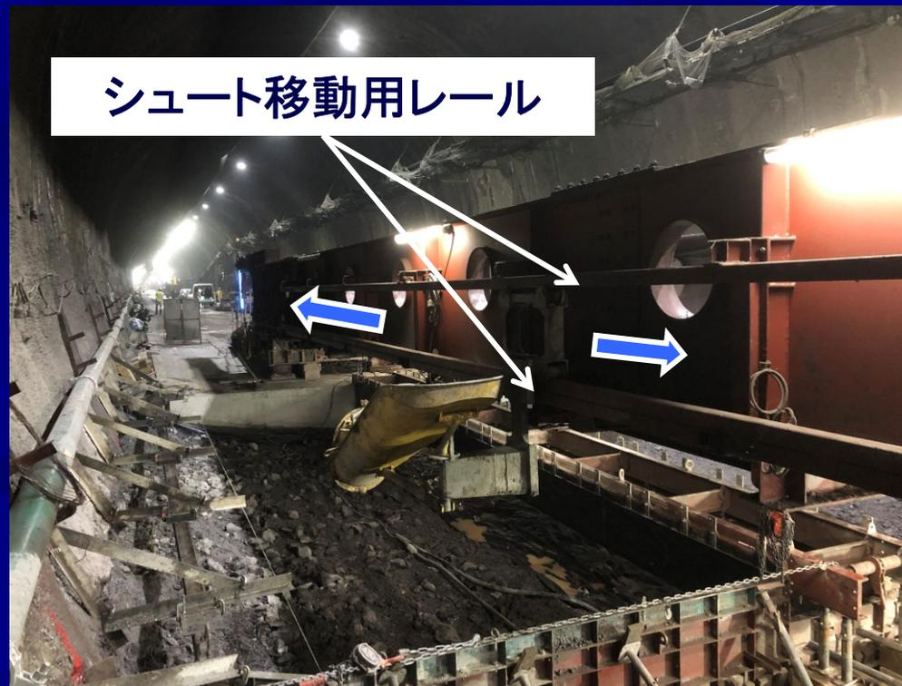
【改善②】 シュートを左右に回転、上下作動可能、折りたたみ伸縮タイプにし、移動用滑車付きブラケットに取り付けて打設位置の細かな調整を可能にしました。
