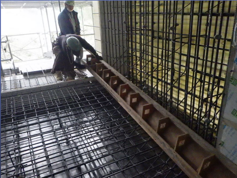
型枠組立状況
