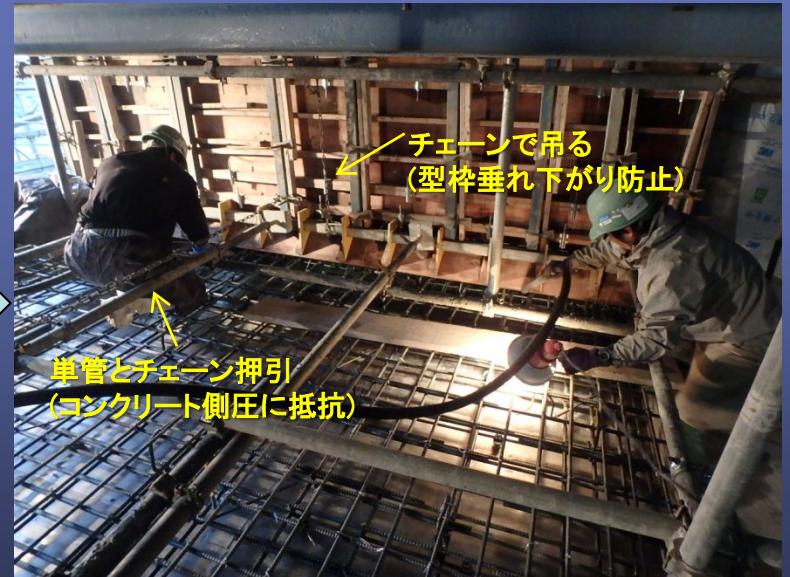
型枠組立完了
