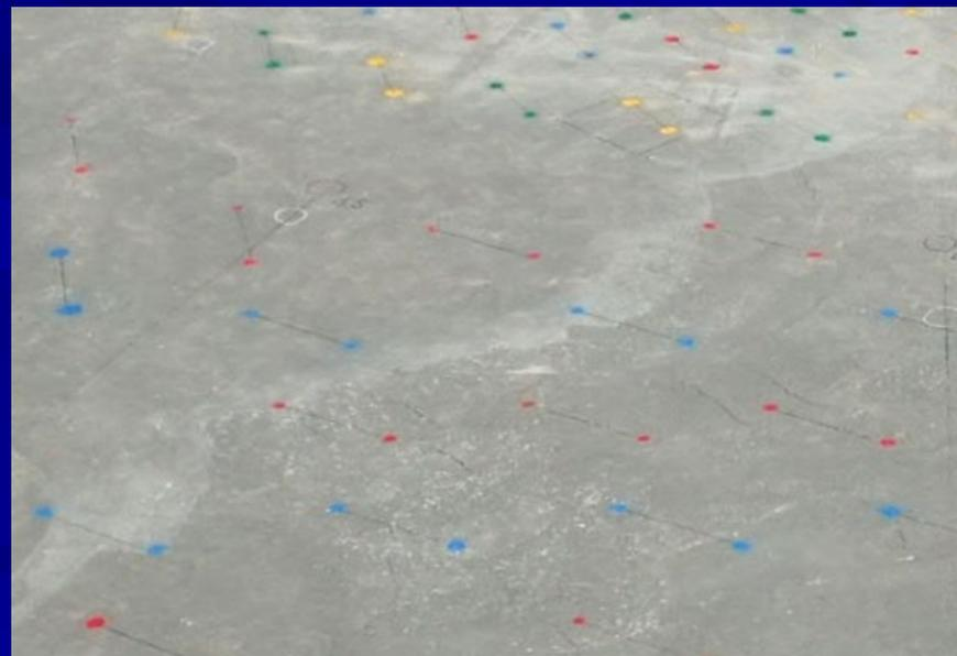
④均しコンクリートにせん断補強筋の位置をマーキングすることにより、ペデスタル部においては下筋組立時の事前配置、外周部においては下筋への掛かり箇所を容易に把握する事ができる。
