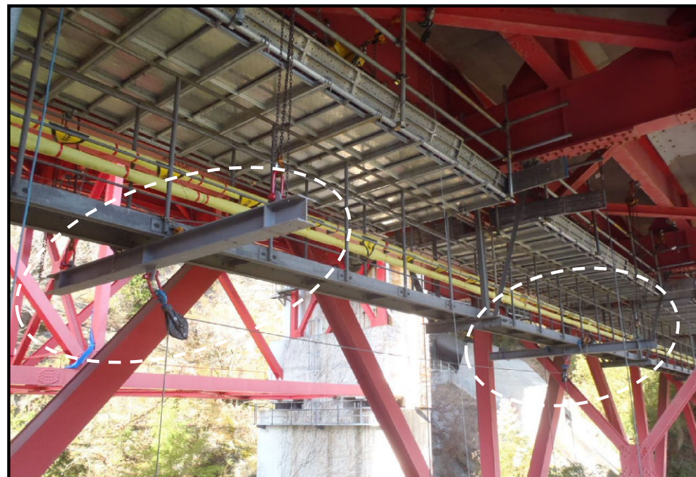
吊天秤によるワイヤー方向変換
