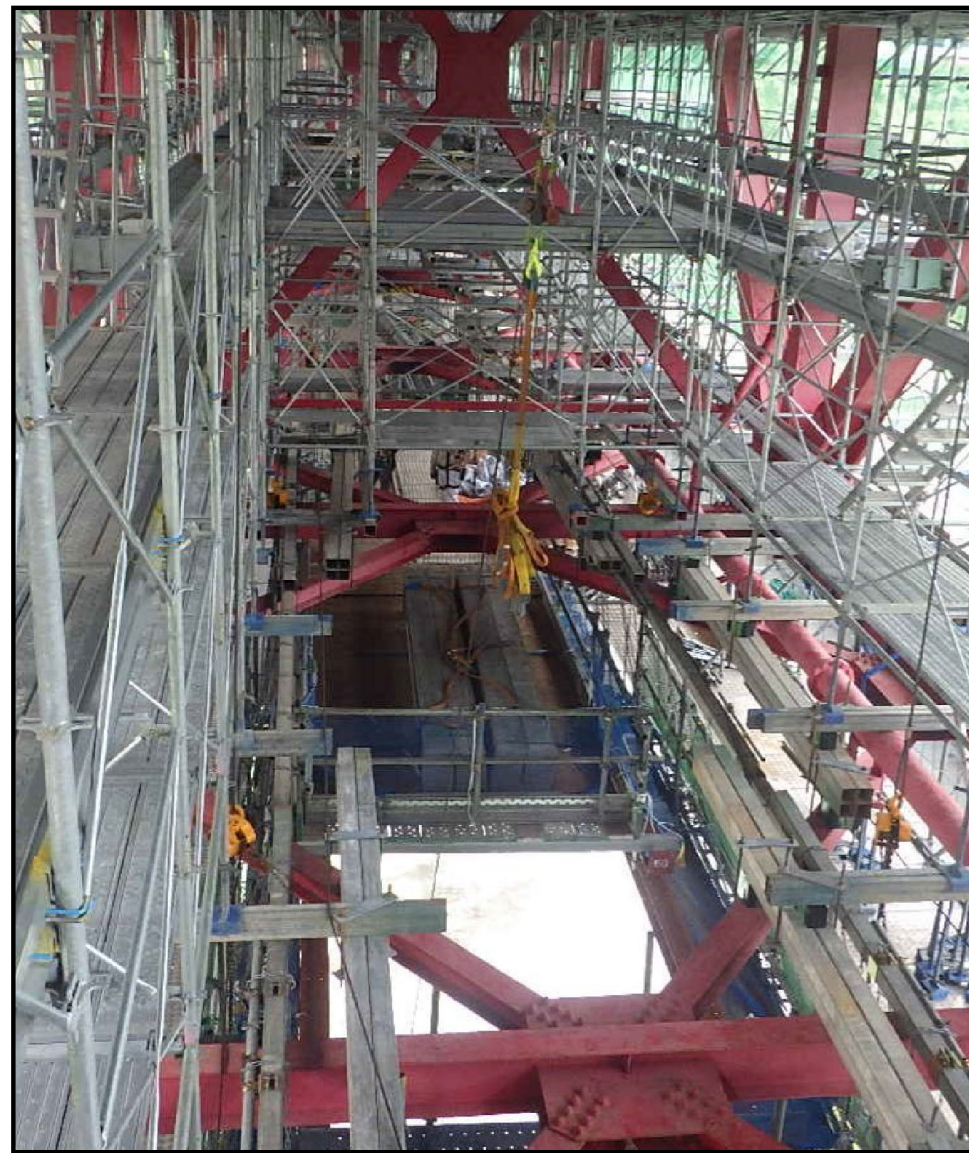
資機材荷下し・積載状況
