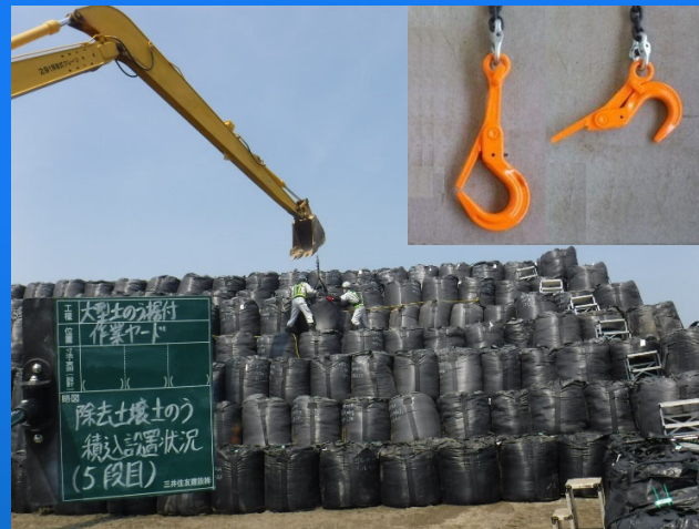
フレコン据付状況 (玉外し2名)
