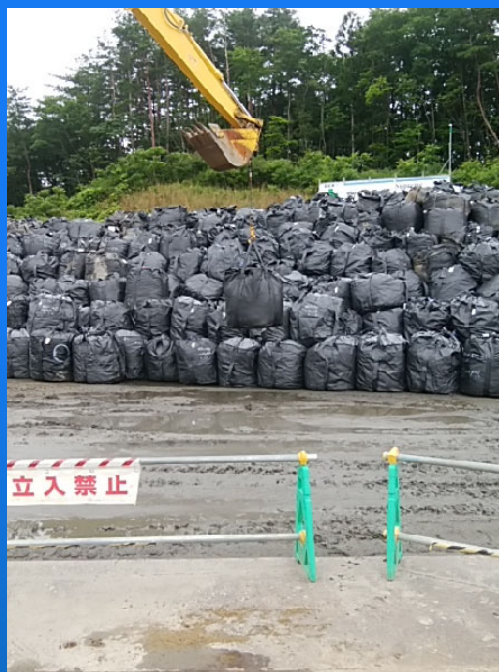
フレコン据付状況 (玉外し0名)
