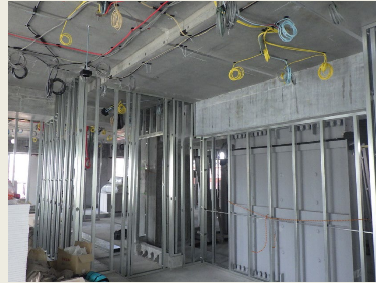
②住戸戸境壁 施工状況
