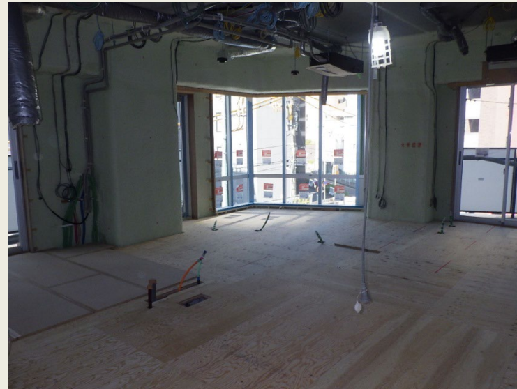
④二重床 施工状況
