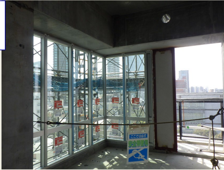
①外壁サッシ 施工状況
