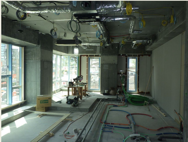
③配線配管 施工状況
