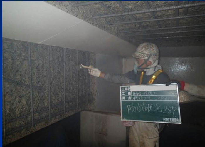
断面修復吹付け(ポリマーモルタル)状況
