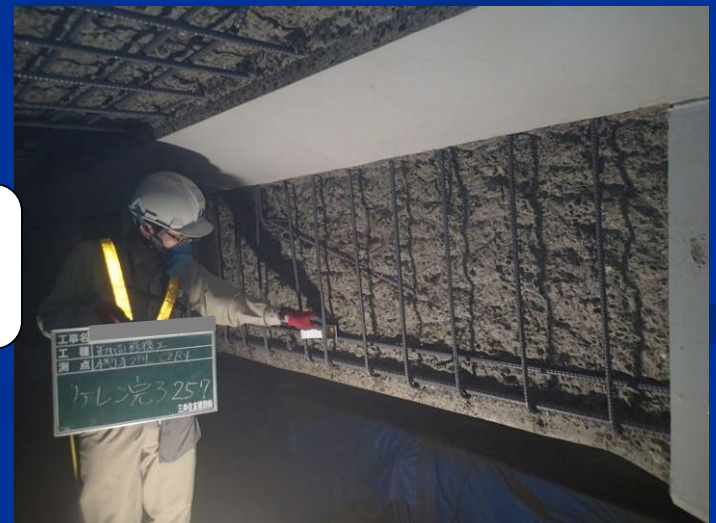
鉄筋ケレン(ブラスト)完了
