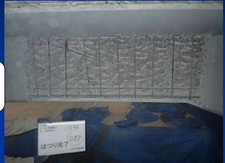
鉄筋ケレン(ブラスト)完了
