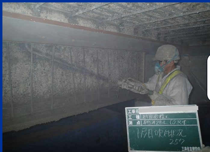
断面修復吹付け(ポリマーモルタル)状況
