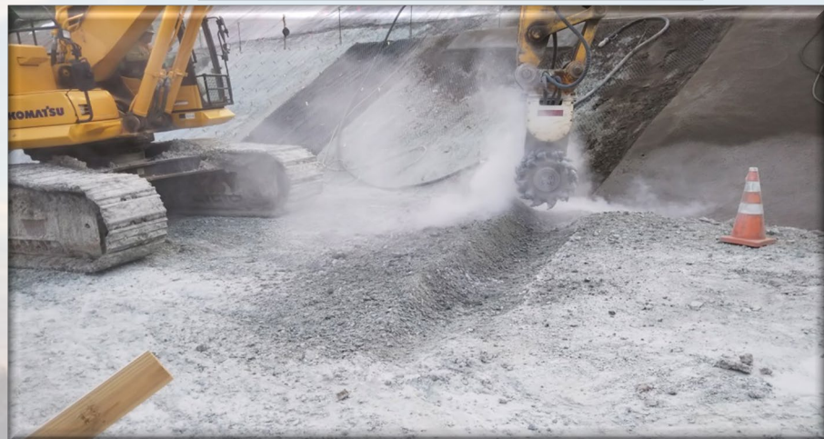
床掘・溝掘り
