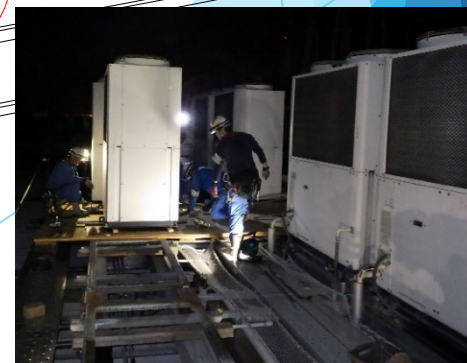
屋上作業の様子
