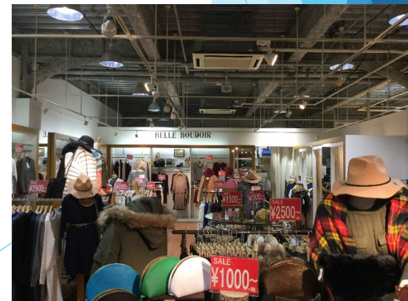
作業前のテナント内
