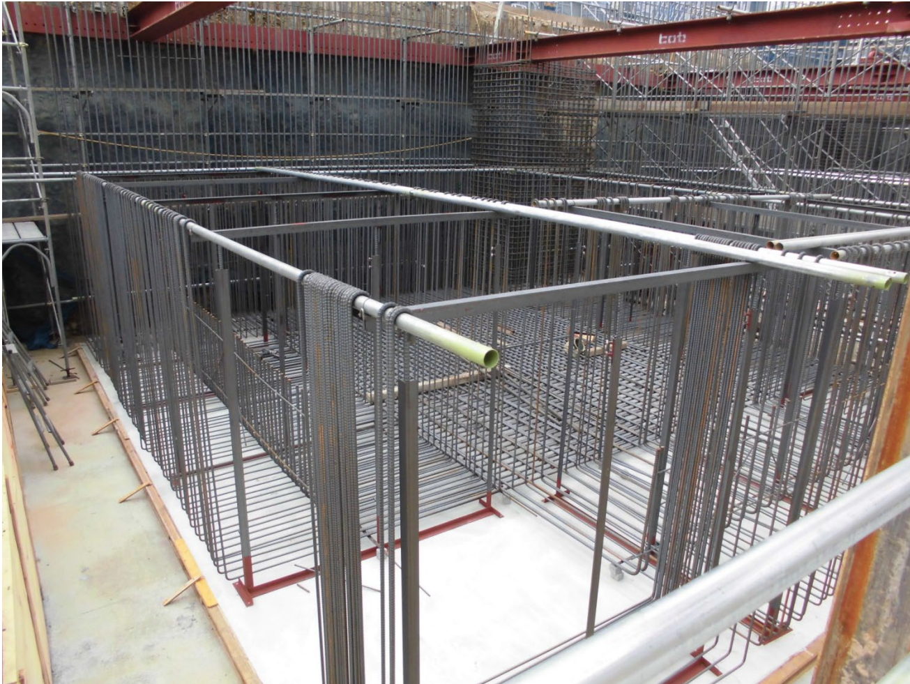
半割スターラップ設置状況
