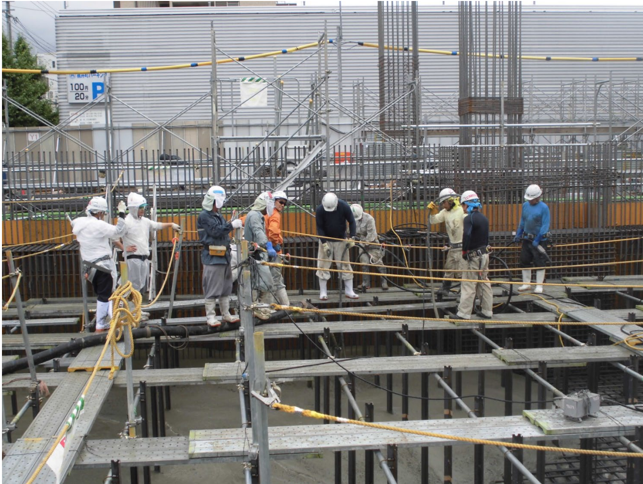
コンクリート打設状況
