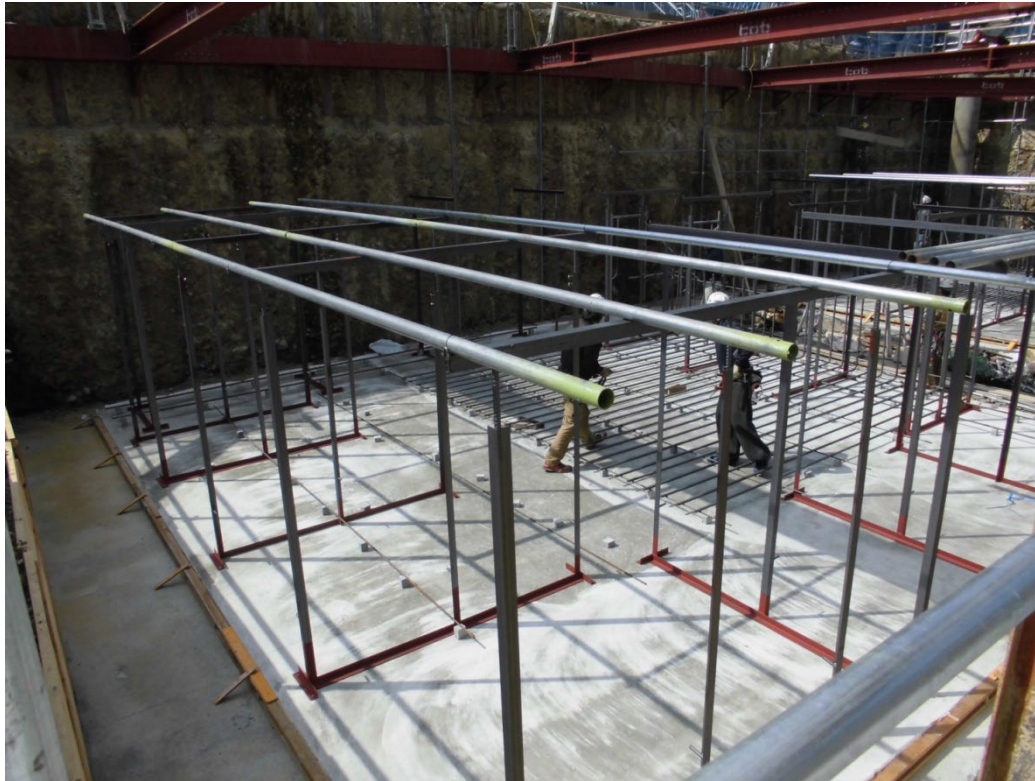
基礎エース設置状況
