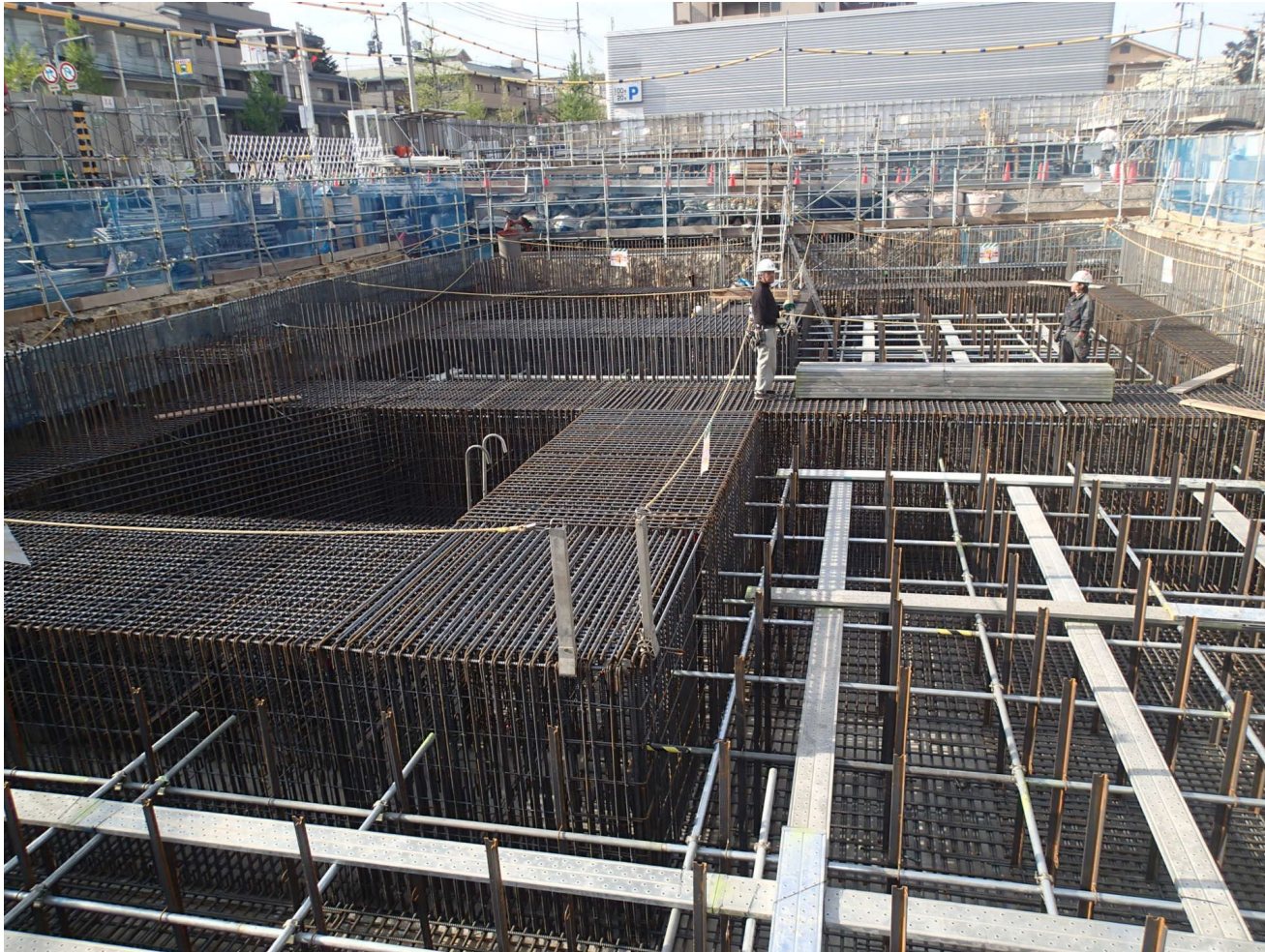
コンクリート打設用足場組立状況
