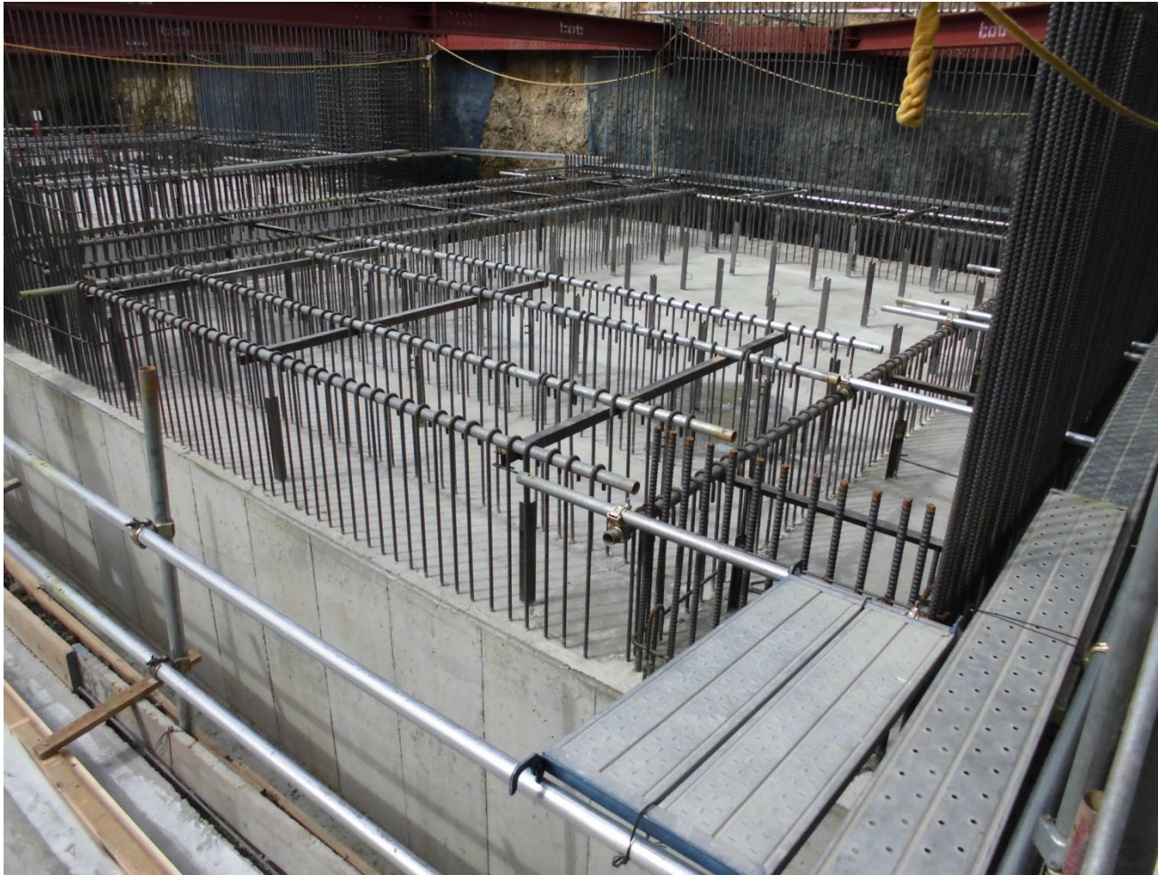
コンクリート打設完了状況
