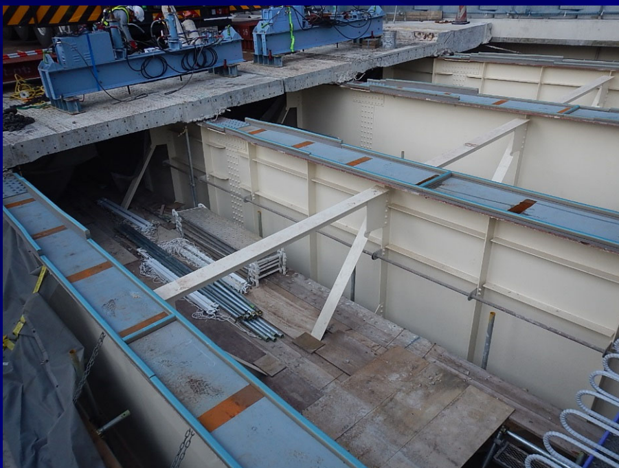
床版撤去後(架設前)の状況
