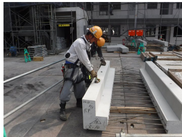
鼻先PCa吊上げ状況①
