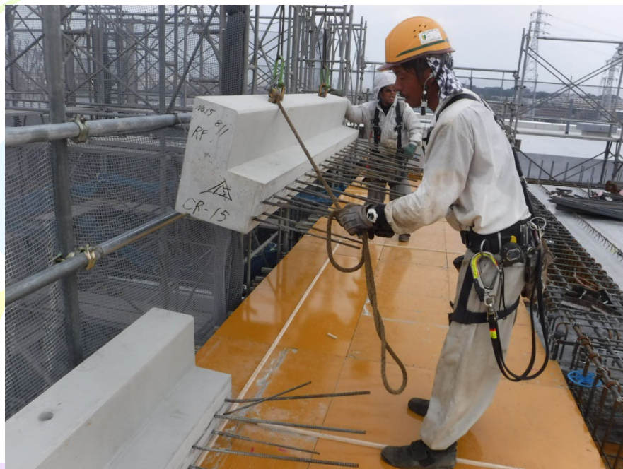
鼻先PCa取付状況①
