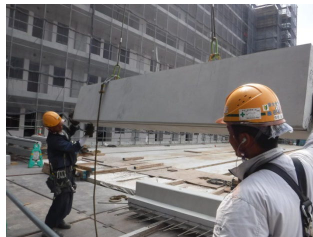
鼻先PCa吊上げ状況②
