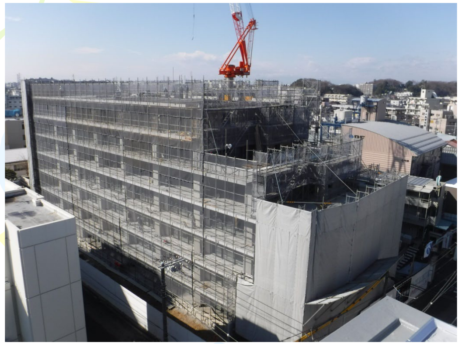
無足場工法 (単管手摺+垂直養生ネット)
