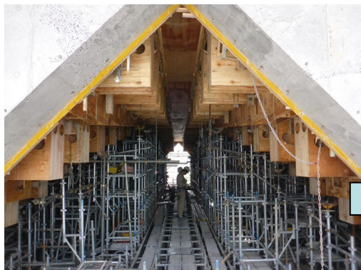
支保工ジャッキダウン
