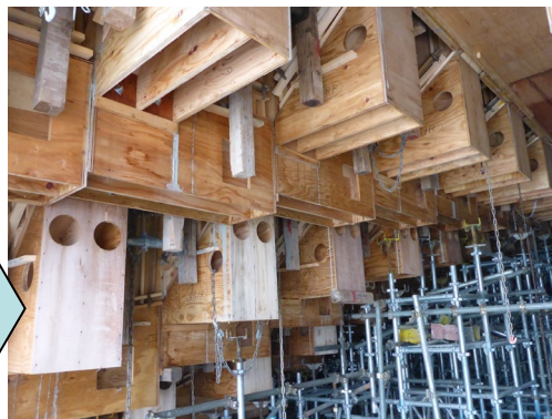
梁底型枠解体
