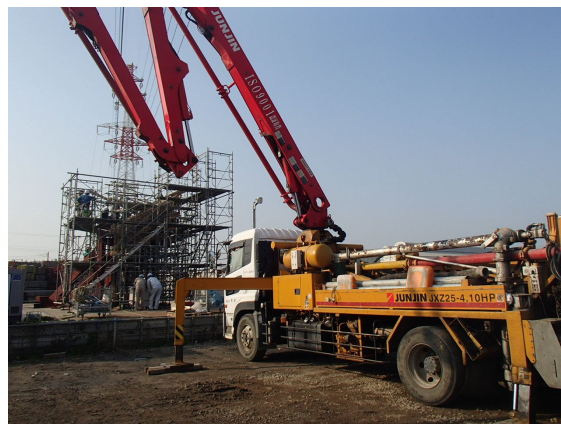
CON打設状況
