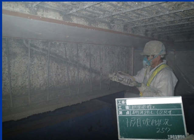
7. 断面修復吹付け状況
