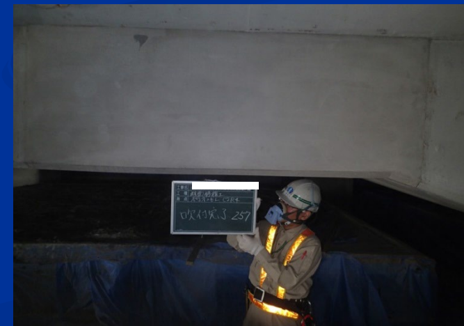
8. 断面修復完了
