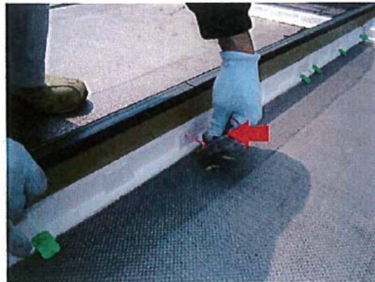
成形伸縮目地材を水系レベルに合わせ、高さ調整ピンで固定します。
