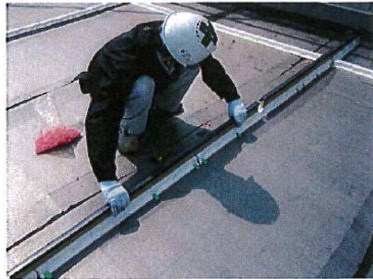
水系レベルに合わせて、成形伸縮目地材のレベルを調整します。調整範囲は、タック台 M で 10 mm、L で 20 mm 以内として下さい。
