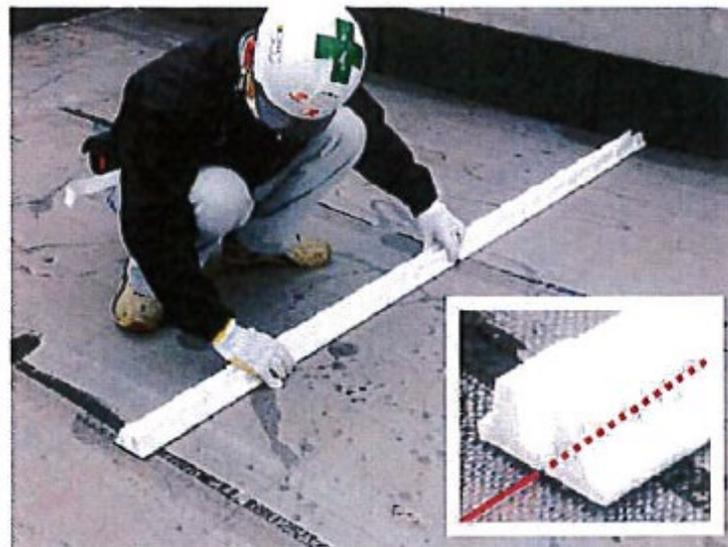
墨に合わせて、タック台を貼り付けます。タック台の中心に溝が入っている為、どの切断面からでも、目地中心線の位置合わせが容易です。
