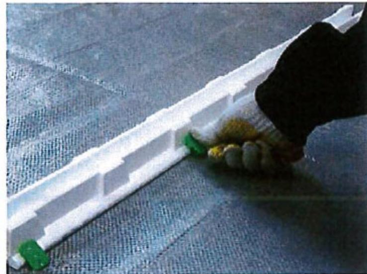
外断熱工法の場合は、固定ピンで断熱材にタック台を固定します。(タック台 1 本当たり、6 個固定して下さい。)
