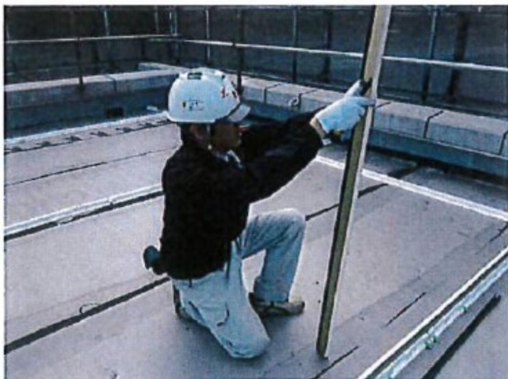
コンクリートレベルより成形伸縮目地材の高さが高い場合は、カッター等で、目地本体をカットして調整します。
