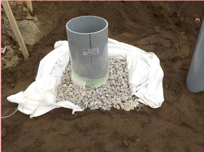
⑥ 押さえ枠引抜き後の状況
