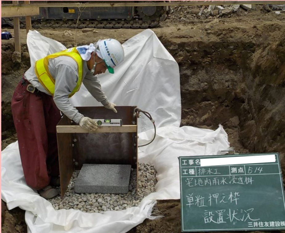
①単粒碎石押さえ枠設置状況
