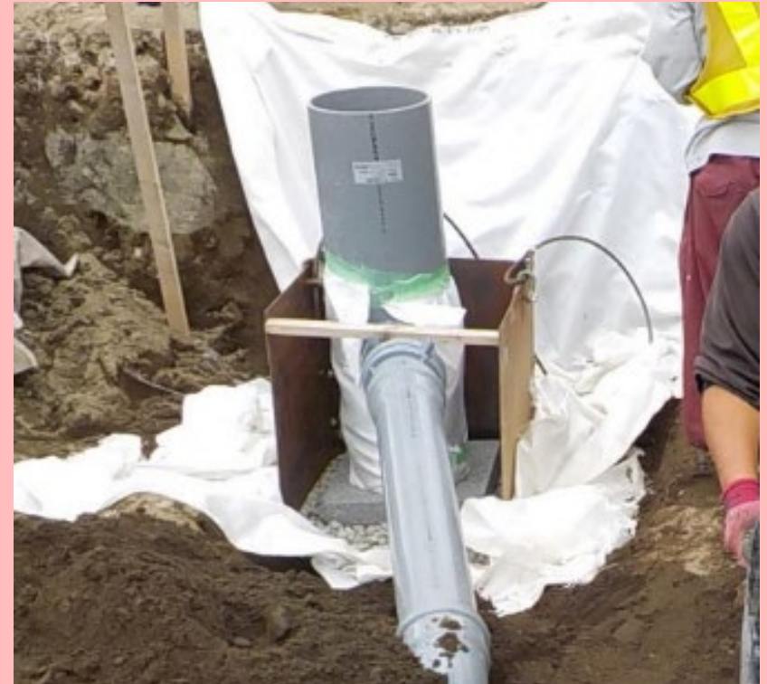
②浸透雨水枡据え付け完了
