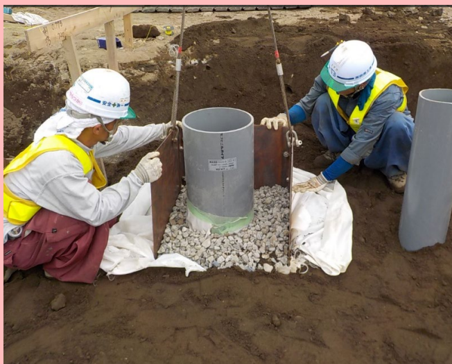
⑤ 単粒碎石押さえ枠引抜き状況
