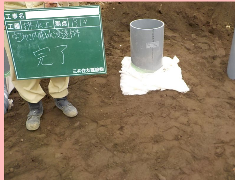
⑦ 上部透水シートを設置し据付完了
