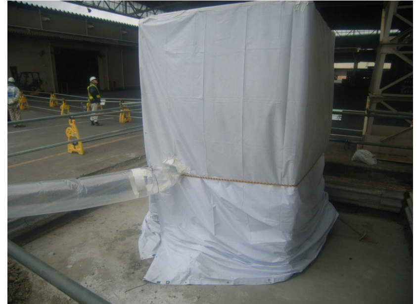
柱基礎への風管接続
