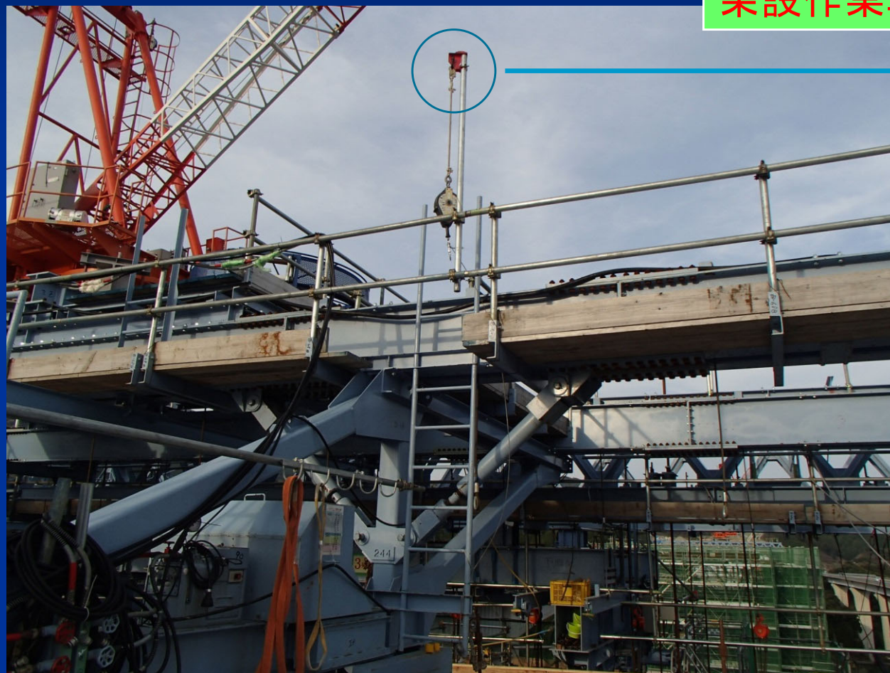
架設作業車に取り付け
