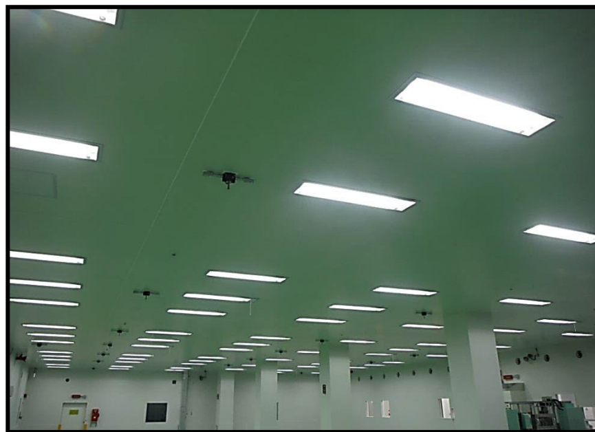
— 器具付け完了 状況 —
