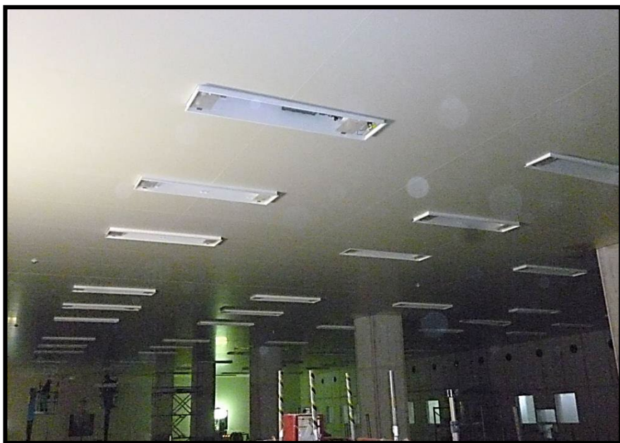
— ボード貼り完了 状況 —
