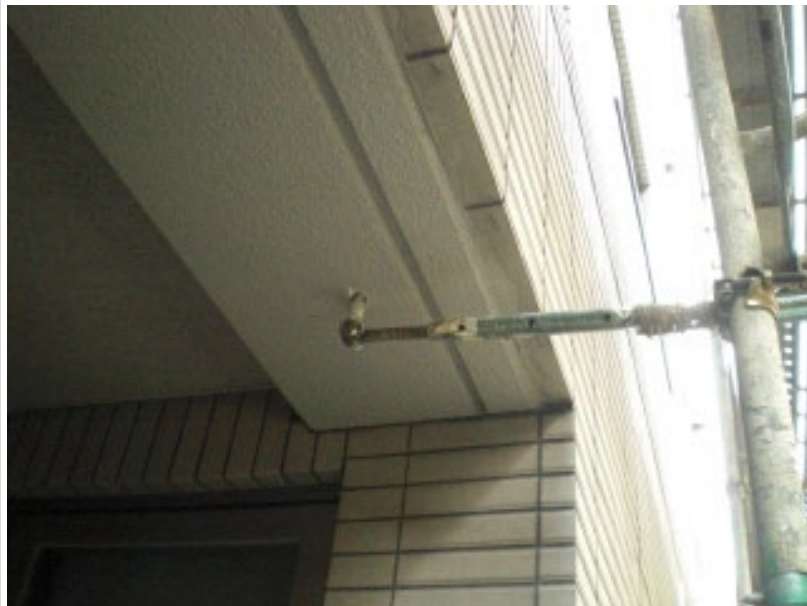
スラブ上裏に壁つなぎを 取り付けた状況
