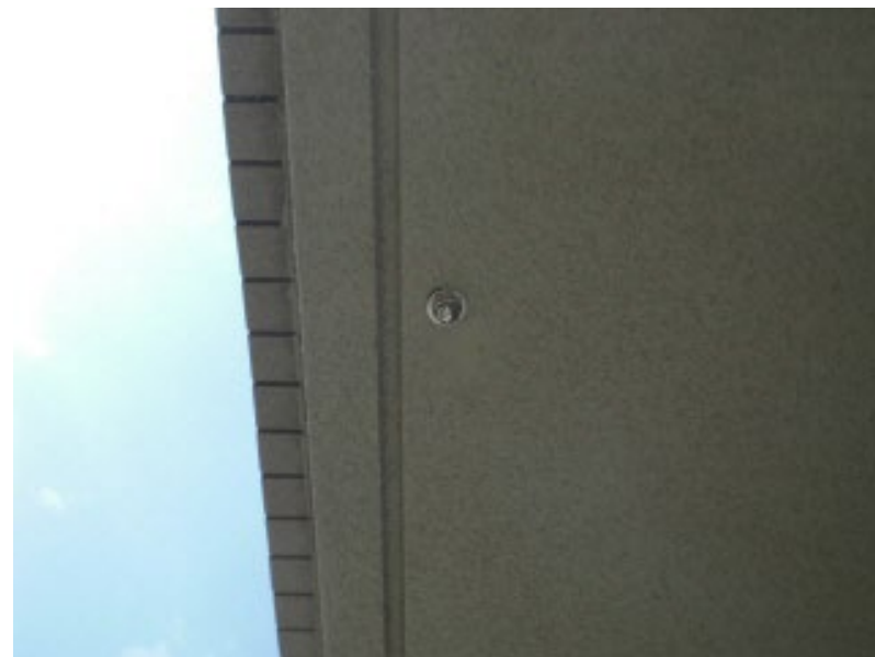
壁つなぎ撤去後の ステンレス製袋ナット 取付け状況
