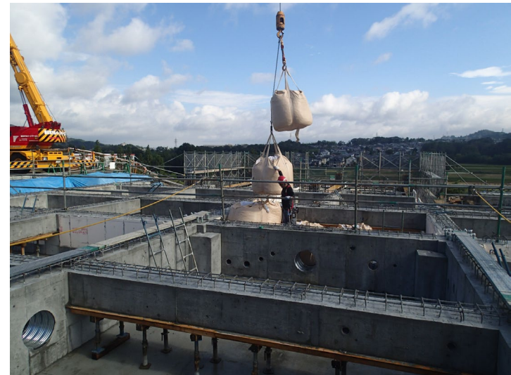
トンパック設置状況
