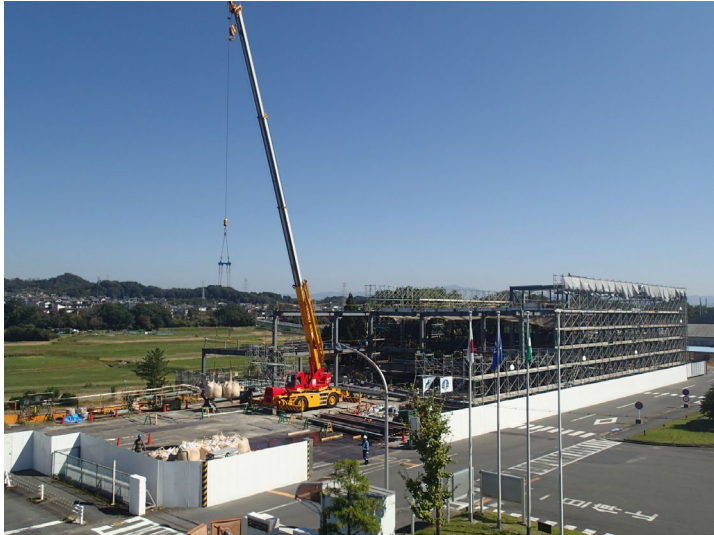
トンパック撤去状況
