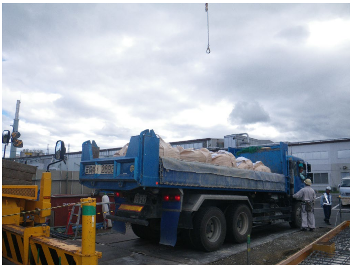
再生砕石入トンパック搬入
