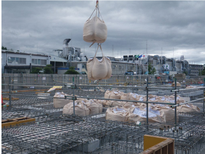
トンパック設置状況
