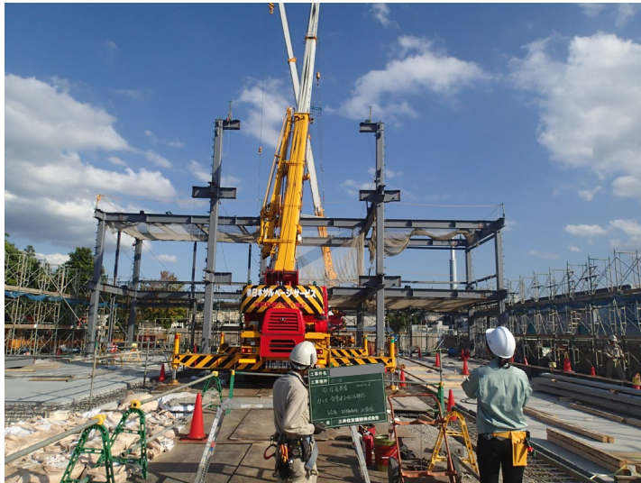
鉄骨建方状況
