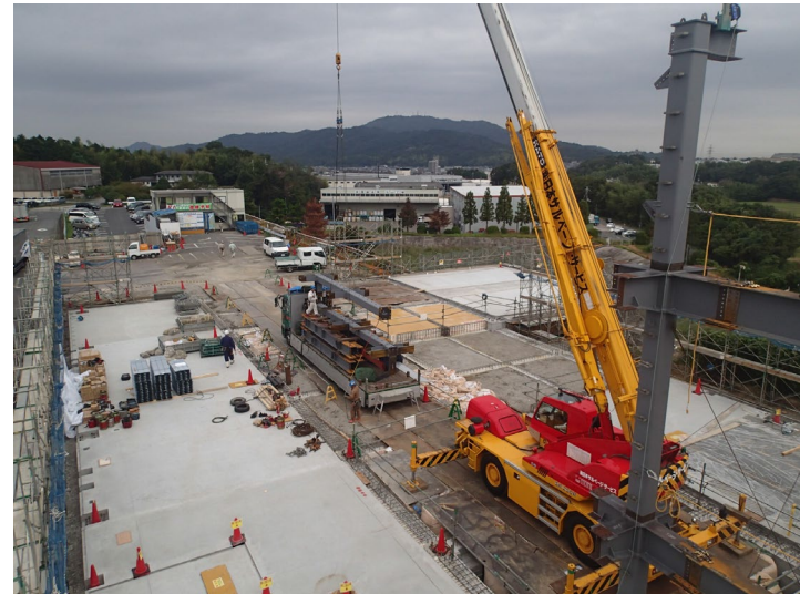
鉄骨建方状況
