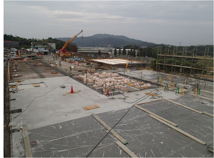
トンパック設置状況
