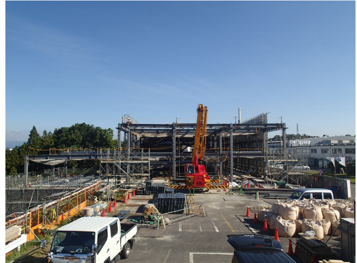
トンパック撤去完了状況
