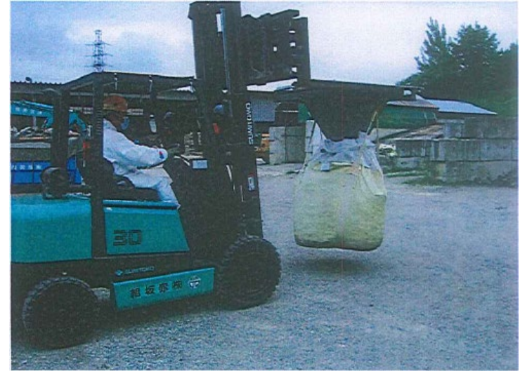
再生砕石入トンパック運搬状況
