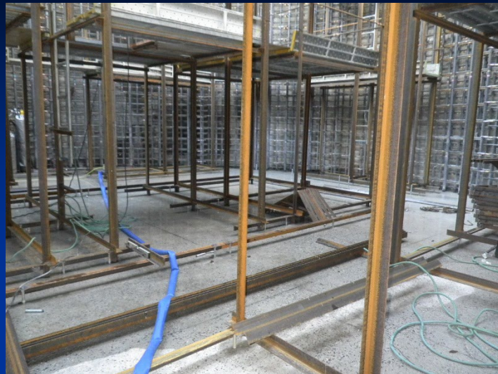
ユニット足場固定状況
