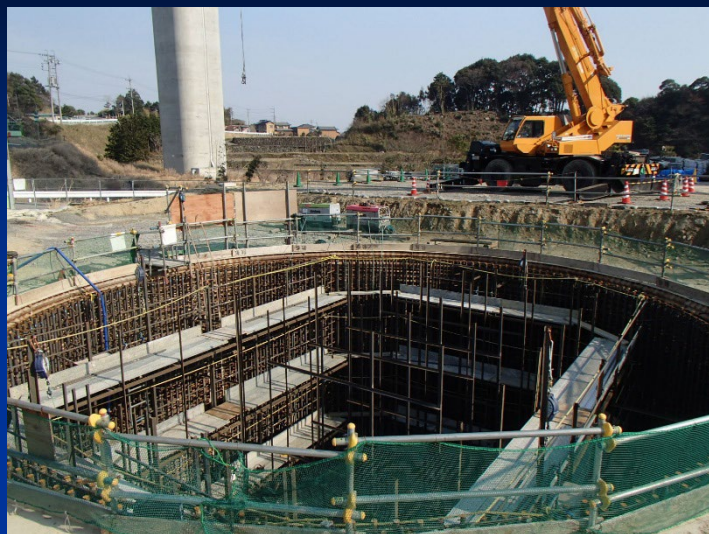
外周足場組立完了
