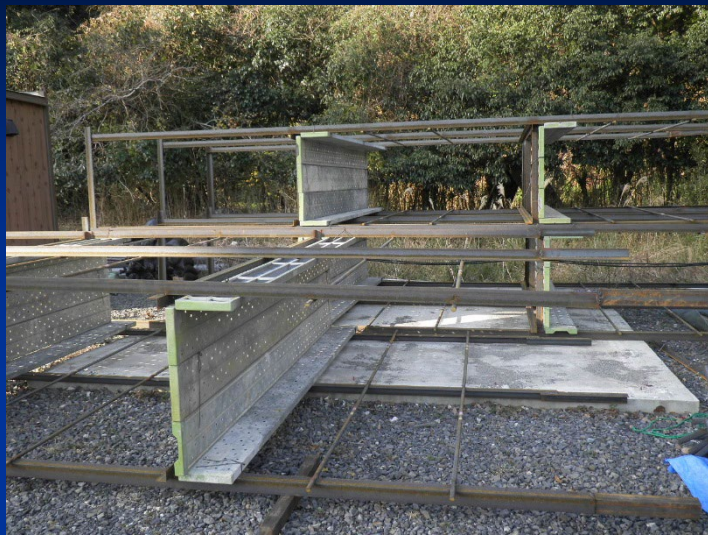
外側足場ユニット化
