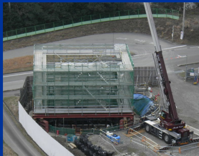
地上部足場組立完了
