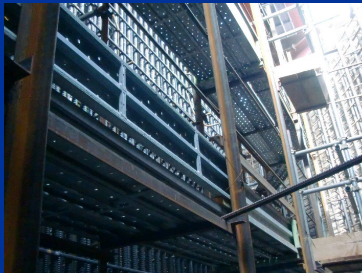
中段足場・通路状況
