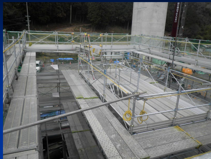
内部足場組立完了
