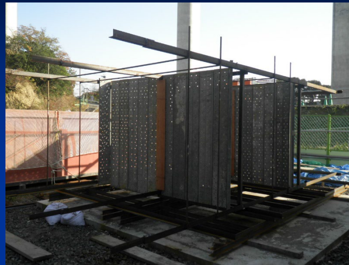
内側足場ユニット化
