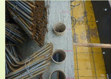
② 再利用塩ビスリーブをPC床開口に差し込む
