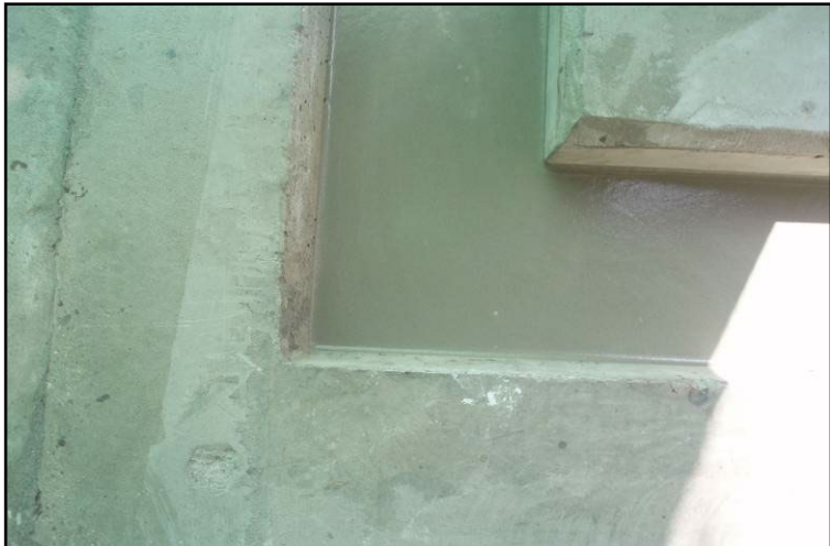
④施工終了(仕上がり)
