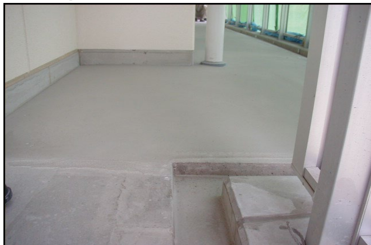
④施工終了(仕上がり)
