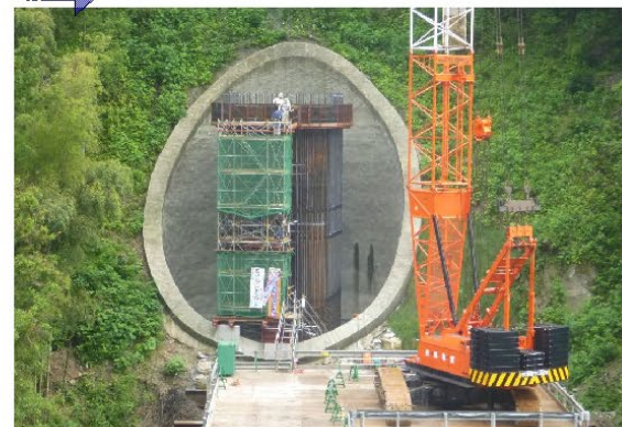
柱筋・足場組立
