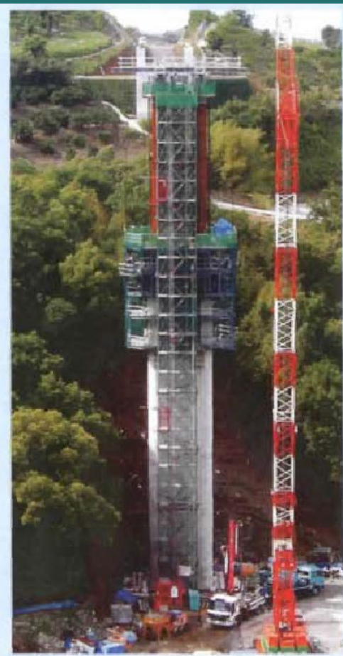
■建設中の鋼管・コンクリート複合構造橋脚
