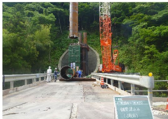
鋼管建て込み
