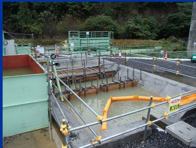
沈砂池構築
