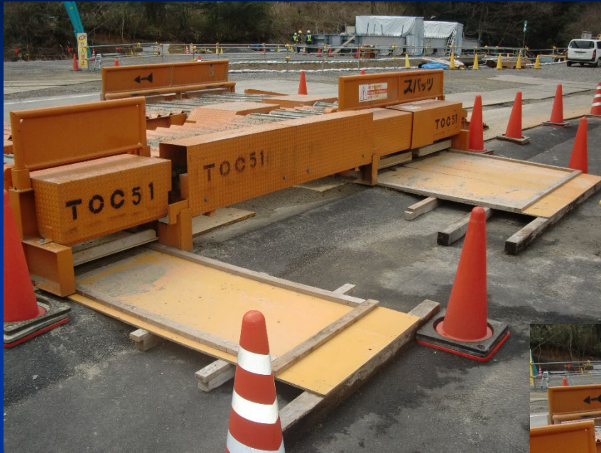
引出し床設置
