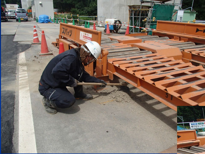
掻き出し状況
