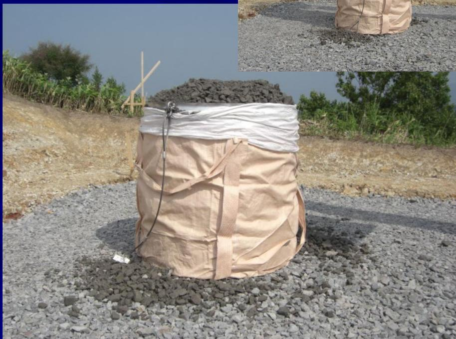
④碎石充填後、バックホウをクレーン仕様にして、コルゲートパイプを引抜く。
