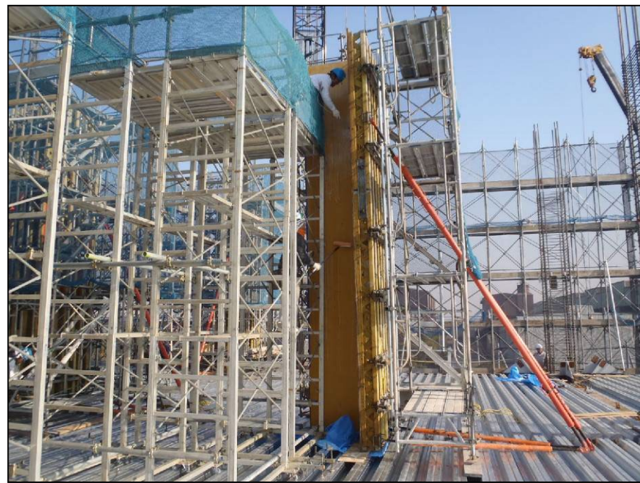
②ケレン・剥離剤塗布
