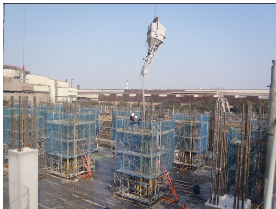
④コンクリート打設
