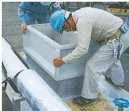
中間ユニット設置
