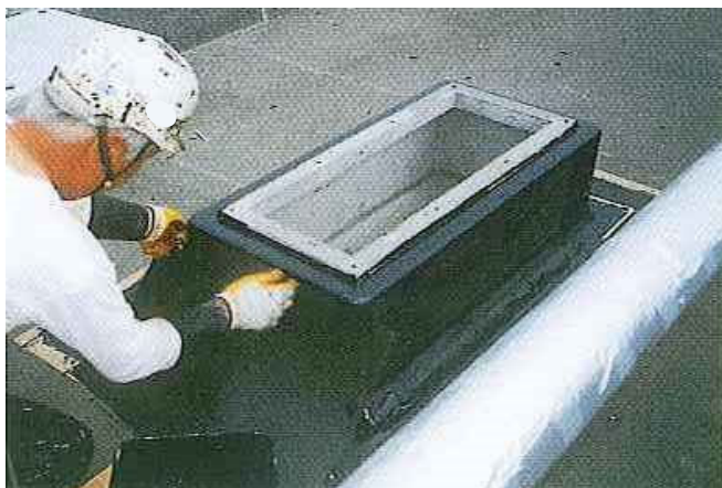
下部ユニット設置⇒防水工事
