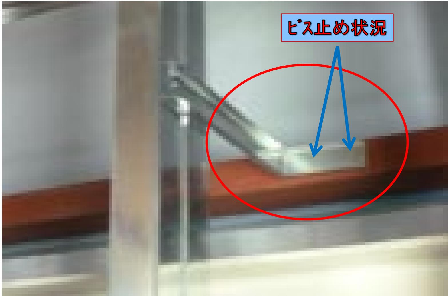
振れ止め曲げ加工状況
