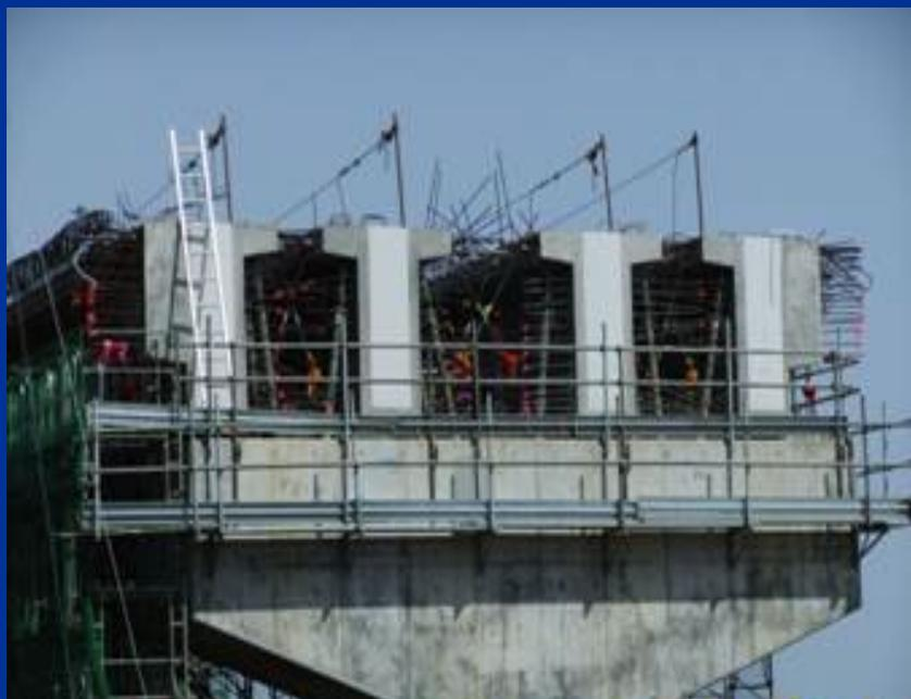
桁架設後の親網設置状況
