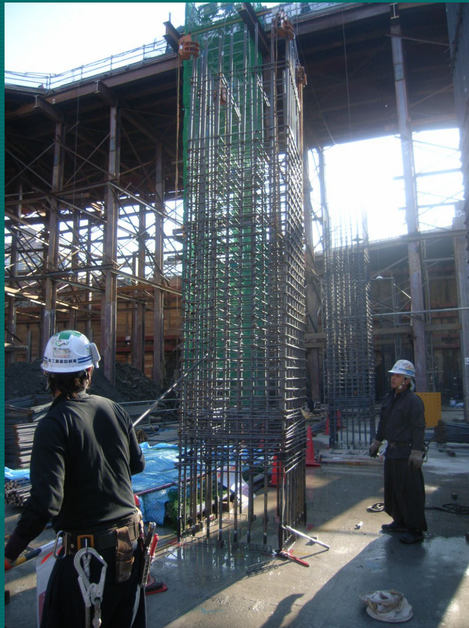
地組による柱筋施工
