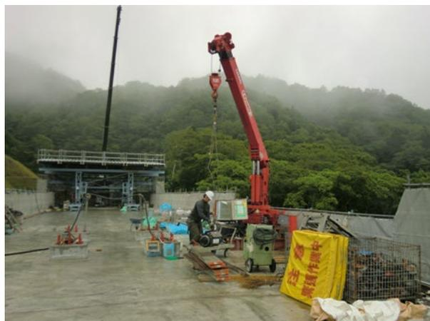
一般的に橋梁の現場で高さが50m以上になると、65t、又は70tクラスのクローラークレーン等を使用する所ですが北海道の場合冬期間に雪の為、工事が出来なかったり、大型クレーンの搬出入が大変になります。そこで、当社で提案したのがユニックを定置式に改良して橋面に上げて使用することで。それによって大型クレーンの使用期間が短縮され、クレーン使用料が大幅に削減できることになりました。現在使用している里音別橋も曲がりくねった林道を15km、大型車だと約1時間かけて出入りしなければなりません。
