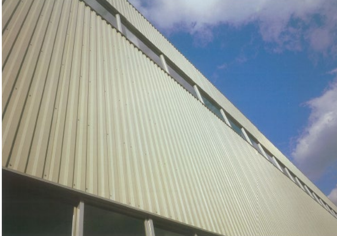
外壁角波サイディングの状況
