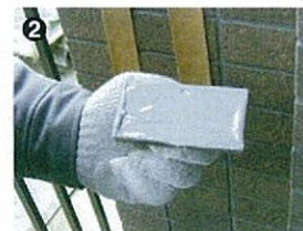
2 アタッチメントに接着剤を塗布
