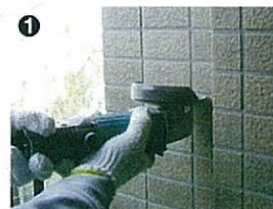
1 試験体周囲の目地を躯体まで切断
