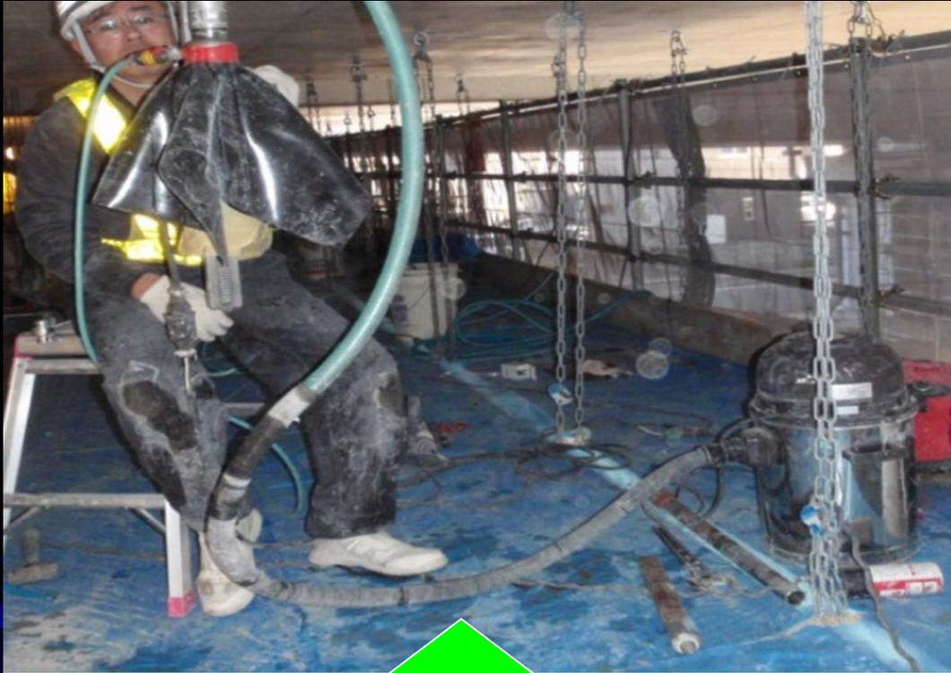
削孔水の給排水用の複数のホースが絡み合い、足元が悪く、移動時にも手間がかかる。
