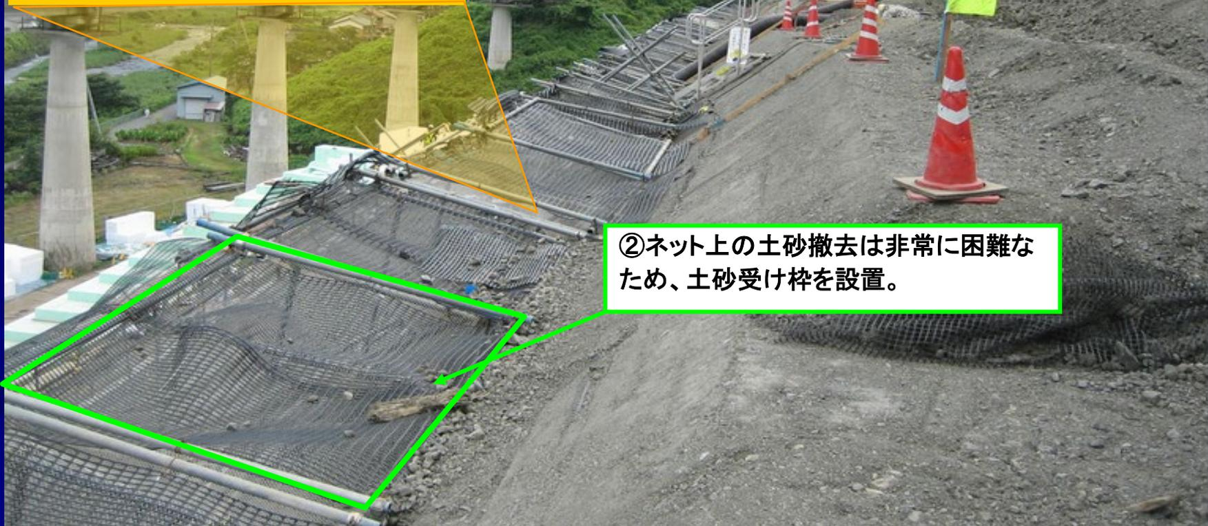
② ネット上の土砂撤去は非常に困難なため、土砂受け枠を設置。
