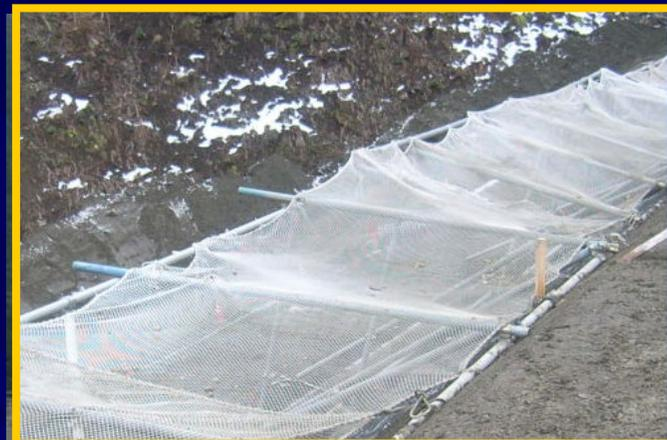
① 防止ネット設置の時、隙間がないようにネットを敷設する。
