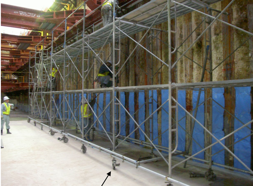
裏面排水施工状況
