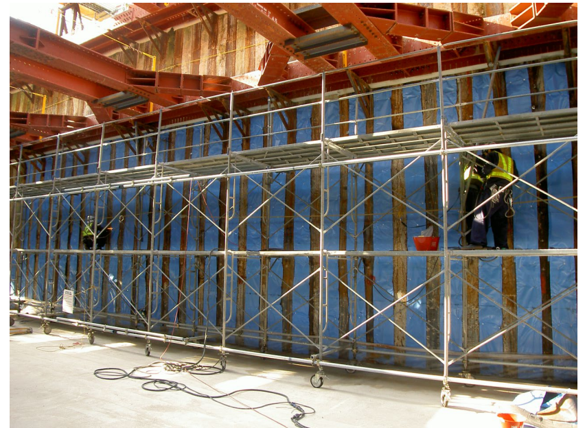
セパスタッド施工状況
