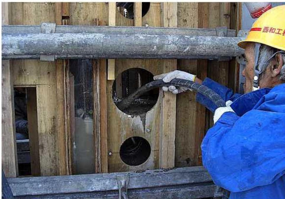
所定の高さまでの打設、締固めが済み次第、塩ビ管を後挿入して設置する。
